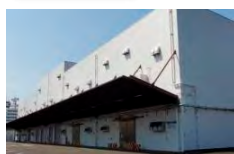
多摩広域防災倉庫
